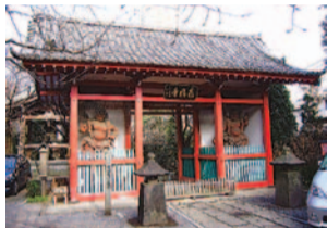
▲修理工事前の仁王門
