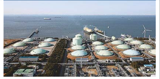
◀袖ヶ浦LNG基地
