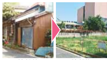
除却前 除却後
