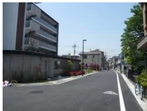
拡幅整備後の道路
