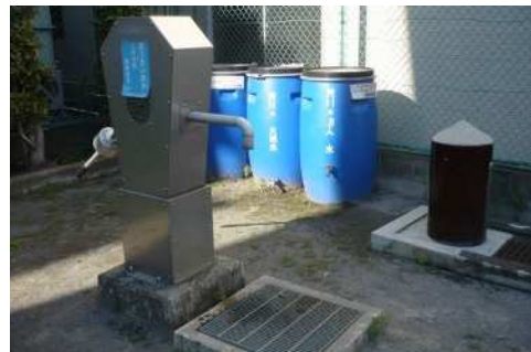
防災井戸、防火水槽
