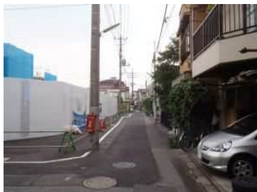
拡幅整備前の道路
