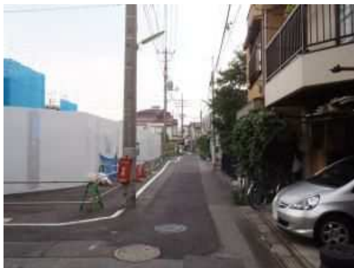
拡幅整備前の道路
