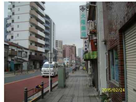
区道荒104号線（千住間道） 電柱
