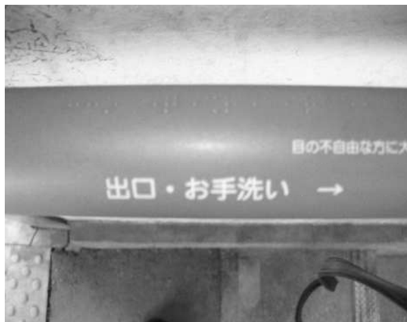
①京成町屋駅点字シート
