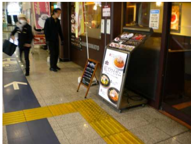
②日暮里構内店舗前誘導・警告ブロック
