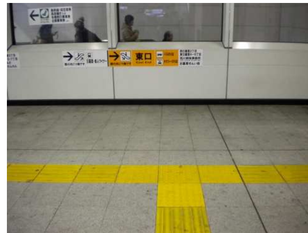
③日暮里改札口外誘導・警告ブロック
