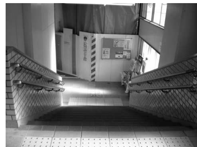
⑥新三河島階段警告ブロック
