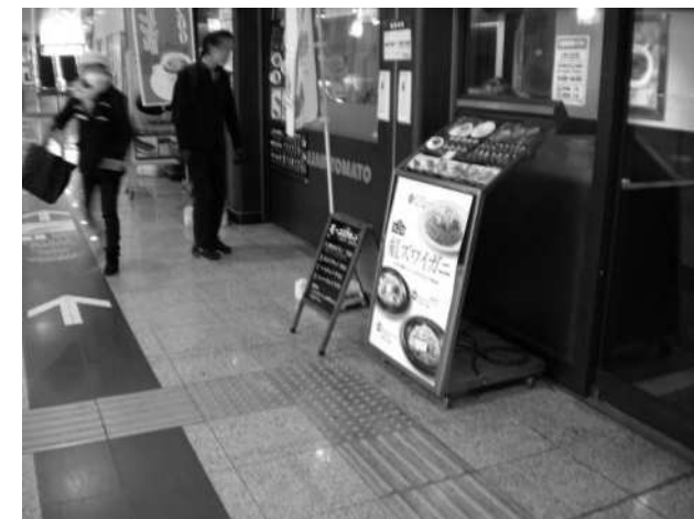
③日暮里構内店舗前誘導・警告ブロック
