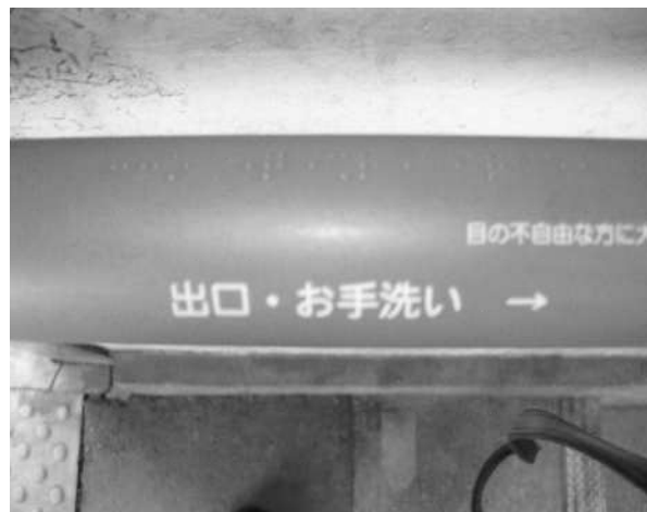
①京成町屋駅点字シート
