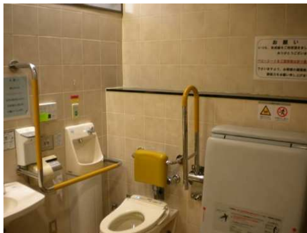
②日暮里多機能トイレベビーシート
