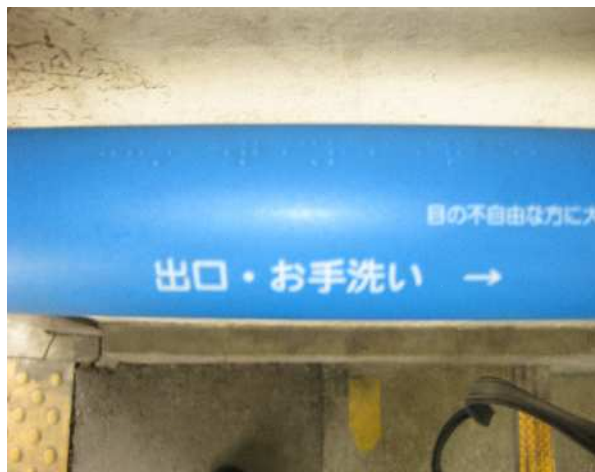
①京成町屋駅点字シート
