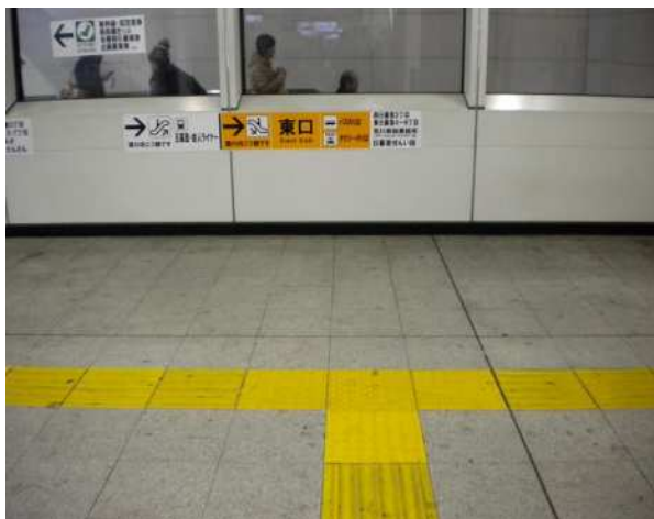
④日暮里改札口外誘導・警告ブロック
