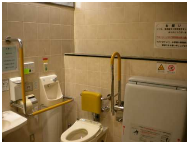
②日暮里多機能トイレベビーシート
