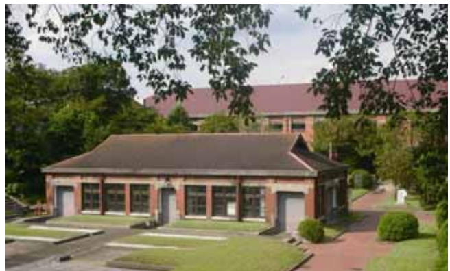
◇旧三河島污水処 ポンプ 分場唧筒場施設◇
