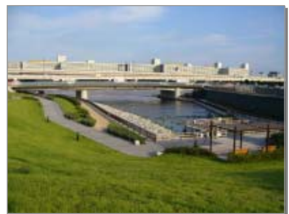
写真 4-18 : 隅田川沿いのスーパー堤防
