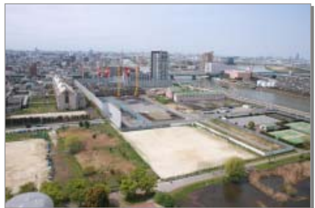
写真 4-2：東尾久浄化センター (平成20年4月現在)
