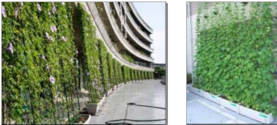
写真 4-8：緑のカーテンの事例 (写真左：区役所本庁舎 / 写真右：区役所北庁舎)
