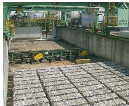
▲鉄分貯留ヤード (中防不燃ごみ処理センター)
