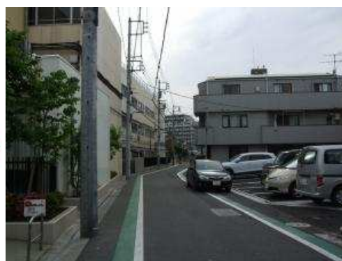
拡幅整備後の道路
