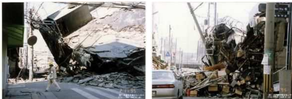
図1-4 建物倒壊による道路閉塞
