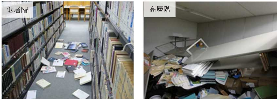
図 1-5 東京都内の同一ビルにおける低層階と高層階の被害状況 出典：「気象庁ホームページ」
