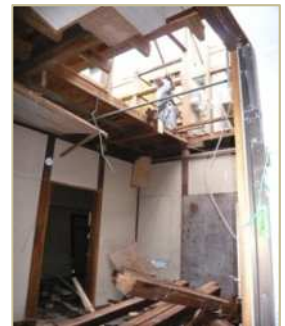
老朽化した木造住宅の除却の様子
