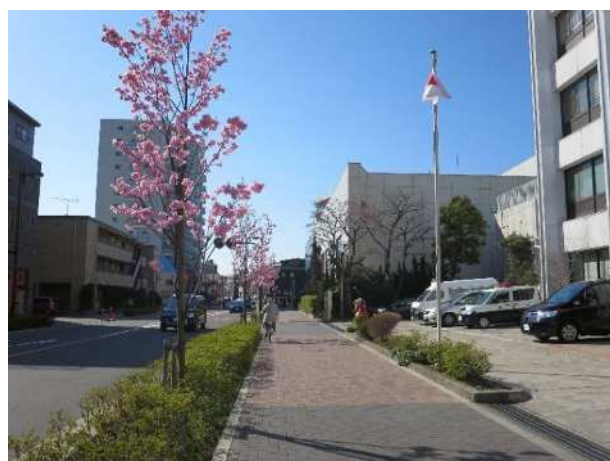
▲無電柱化を実施した道路（千住間道）
