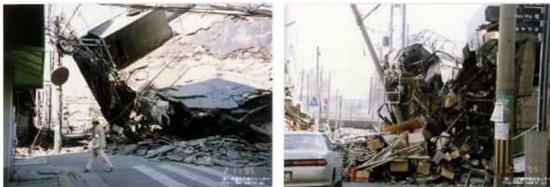
図 1-4 建物倒壊による道路閉塞
