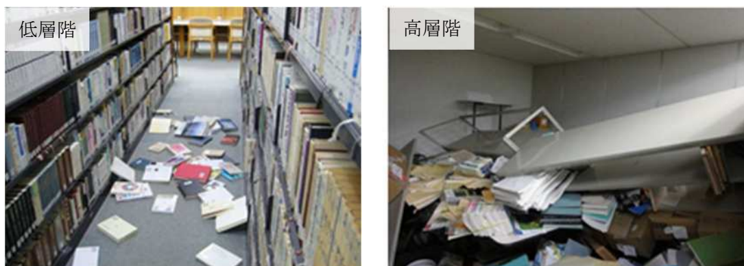
図 1-5 東京都内の同一ビルにおける低層階と高層階の被害状況
