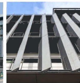
ルーバーに鉄を使用
