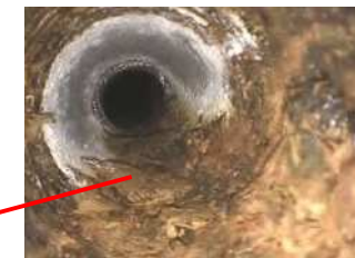
＜配管内部の劣化＞
