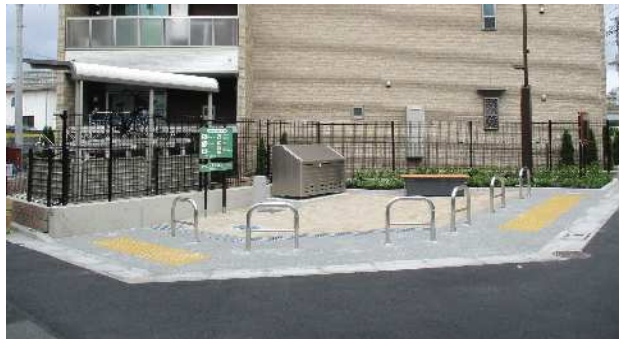
西尾久六丁目東防災スポット
