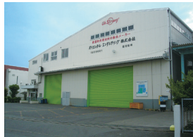
川越工場外観
