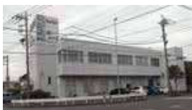
本社兼ショールーム 外観
