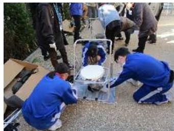
仮設トイレの設置
