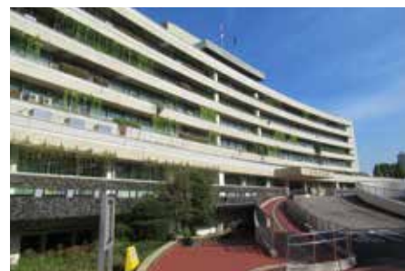
◀現在の 荒川区役所本庁舎
