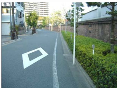
地域の景観に溶け込む旧千住製絨所跡地に残るレンガ塀（現荒川工業高校）
