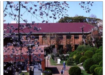
国の重要文化財に指定されているレンガ造の旧三河島污水処分場ポンプ場（現三河島水再生センター）
