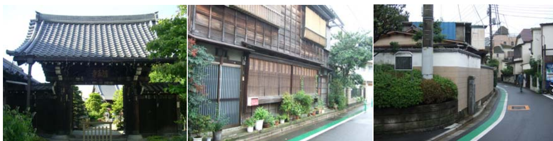
瓦や木材等の落ち着いた自然素材の使用例（西日暮里三丁目）
