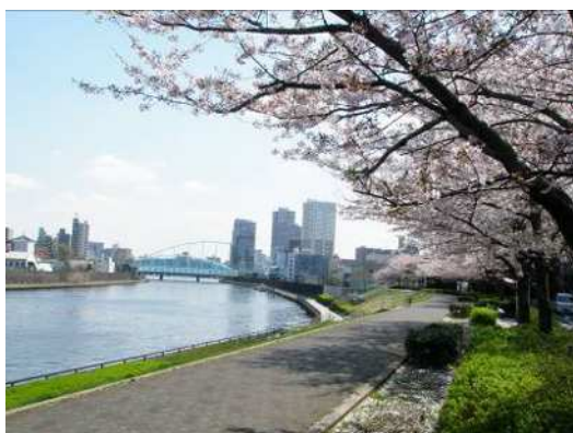
スーパー堤防整備区間
