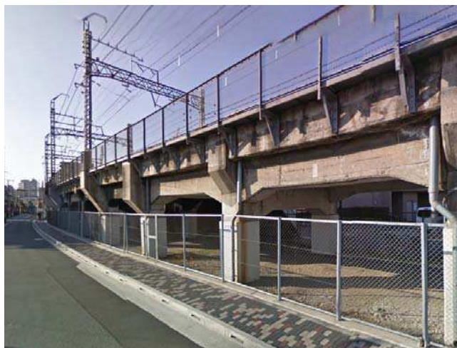
今後の有効活用が望まれる鉄道高架下
