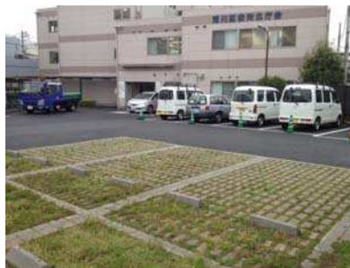
緑化ブロックの利用例(荒川区役所北庁舎駐車場)
