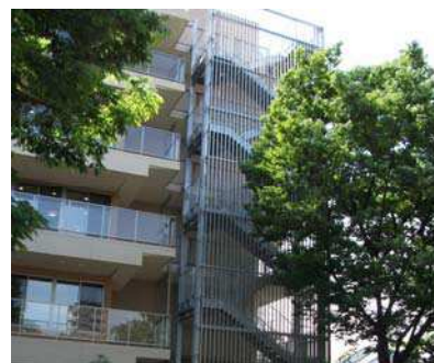
ルーバーで目隠した例
