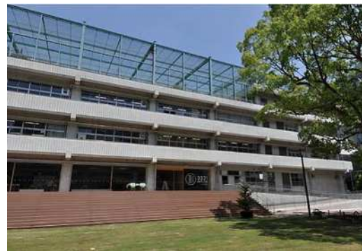
公共建築物とオープンスペースの一体化を図った例 (千代田区・ちよだアートスクエア)
