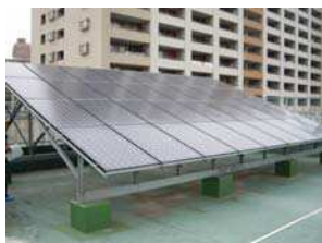
太陽光パネル設置例(荒川区立第七峡田小学校)
