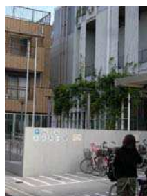
低中層部の壁面緑化の例 (荒川区立峡田ふれあい館)
