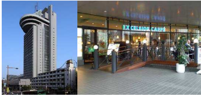
通りに面する庁舎の1階のカフェ店舗を導入した例 (文京シビックセンター)
