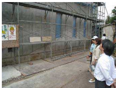
外壁の素材・色彩の現場検証
