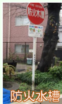
防火水槽 地下に消火用の水の 貯水槽があります
