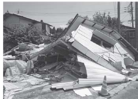
写真：熊本地震の建物被害
