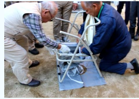
③便座を組み立て、マンホールの上に設置する
