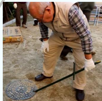
①マンホールの蓋を開ける
