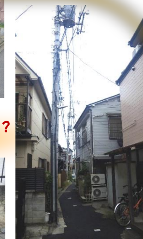
狭い道路にある大きな電柱
