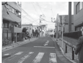
拡幅がほぼ完了した道路（幅員9m）
