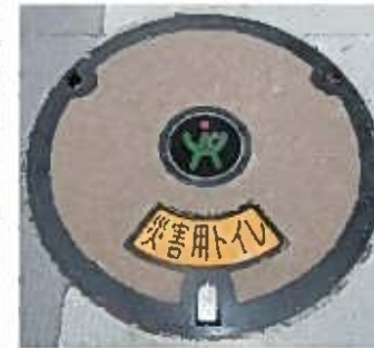
マンホールトイレ
