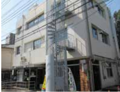
◀ 尾久区民事務所の外観
