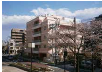
◀障がい者地域生活支援施設（スクラムあらかわ）の外観
