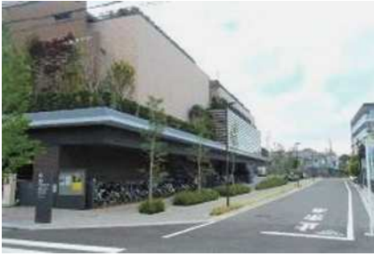
▲無電柱化済み の道 (ゆいの森周辺道路)
