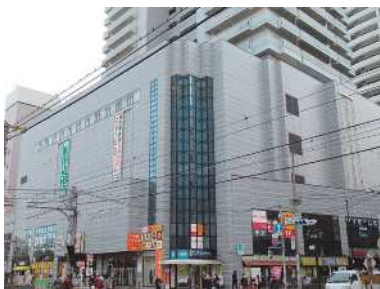
◀ムーブ町屋(3・4階部分)
