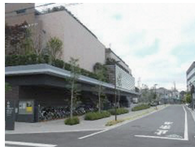
◀無電柱化済の道 (ゆいの森周辺道路)
