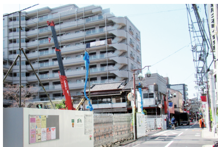
◀東尾久本町通りふれあい館の建設工事の様子
