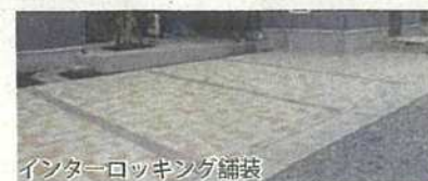
インターロッキング舗装
