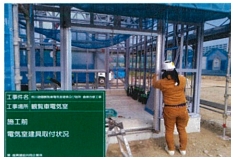
建具取付状況
