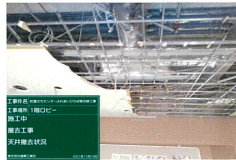
内装解体撤去状況
