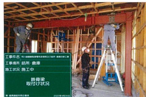
鉄骨建方状況
