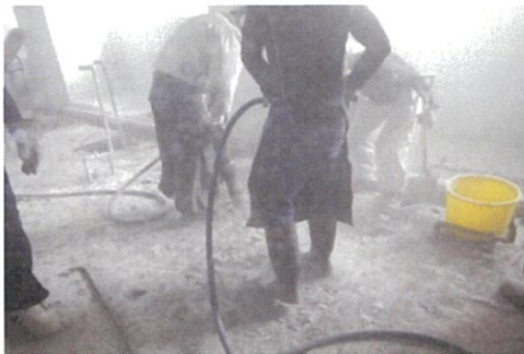
コンクリート研り状況
