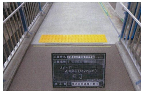
スロープ施工状況
