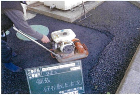
アスファルト舗装状況
