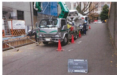
コンクリート打設状況
