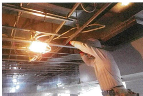
天井下地組状況
