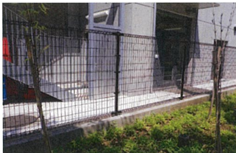
フェンス施工状況
