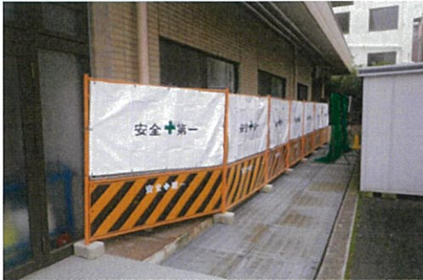
仮囲い設置状況
