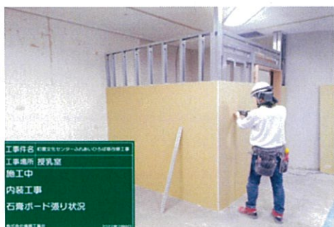
壁ボード張り状況
