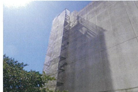
外部足場組立状況
