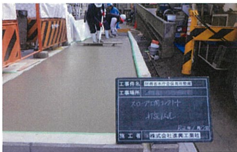
スロープ施工状況
