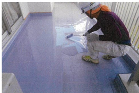
防水施工状況
