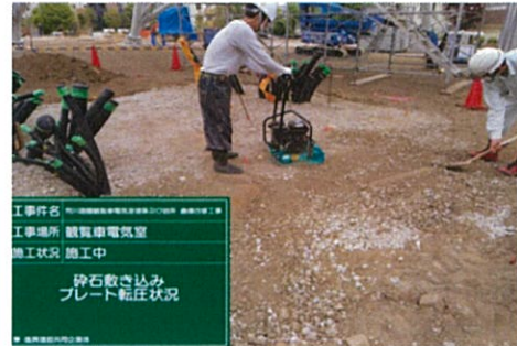
砕石敷転圧状況
