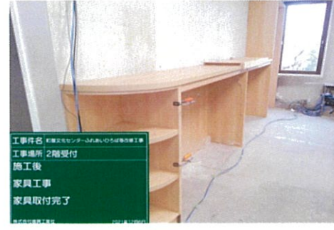
家具取付状況
