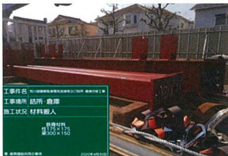
鉄骨材搬入状況
