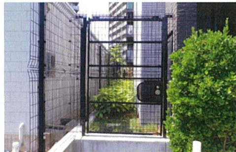
門扉施工状況
