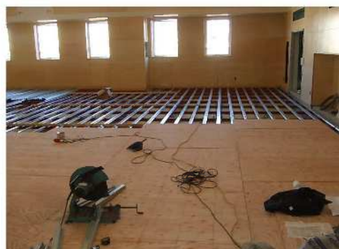
置床組立状況
