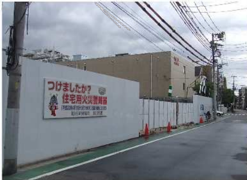
仮囲い及びシートゲート設置状況
