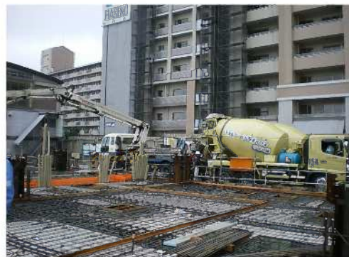
コンクリート打設状況
