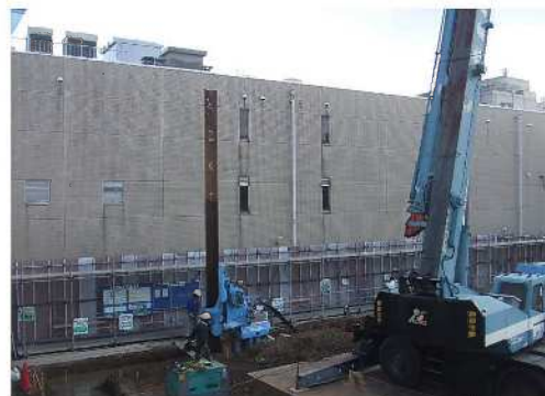
シートパイル埋込状況
