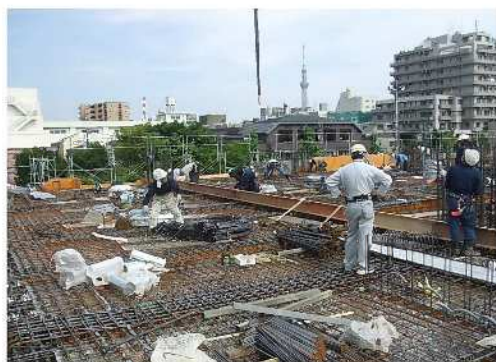
型枠・鉄筋設置状況
