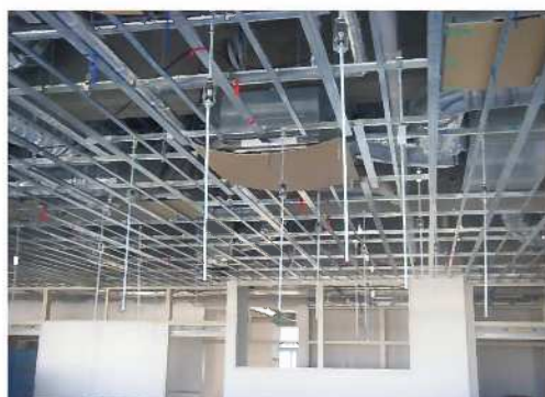
軽鉄組立状況
