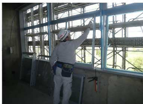
アルミサッシ取付状況
