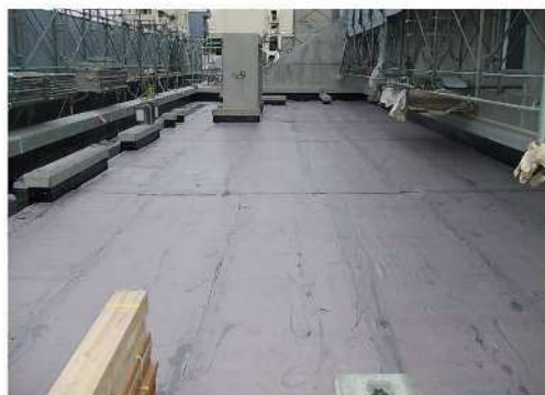
屋上防水状況
