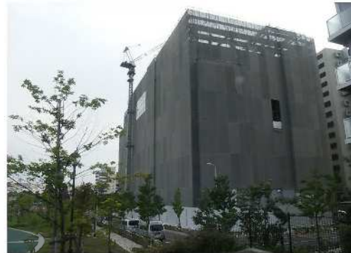
外部足場組立状況
