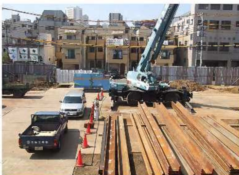
シートパイル搬入状況
