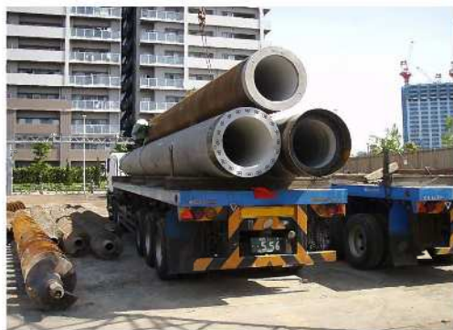
既製コンクリート杭搬入状況
