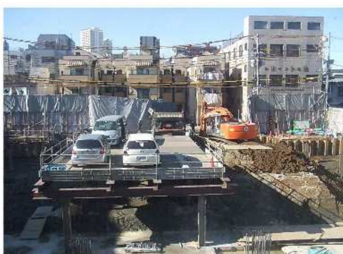
残土搬出状況
