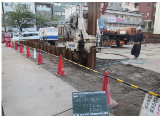
山留シートパイル打設状況
