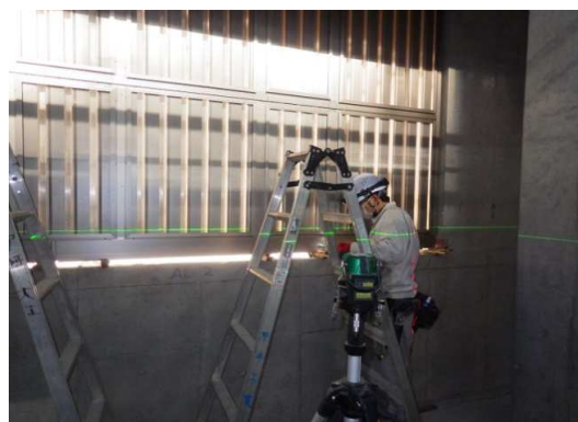
金属製建具取付状況
