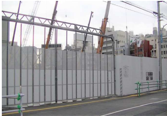
仮囲い・仮設ゲート
