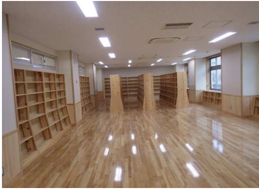
家具工事・床工事
