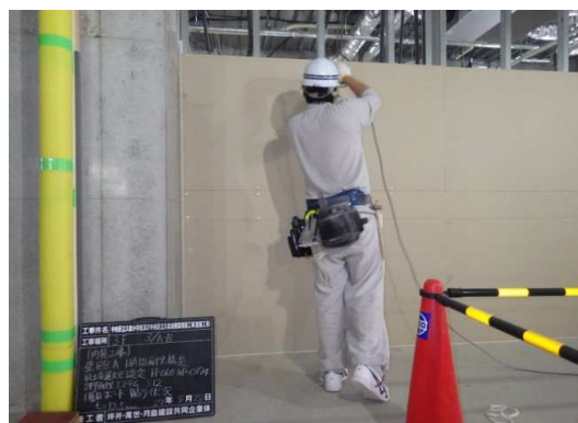
ボード貼り状況
