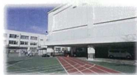
小学校の跡地を利用しております。
