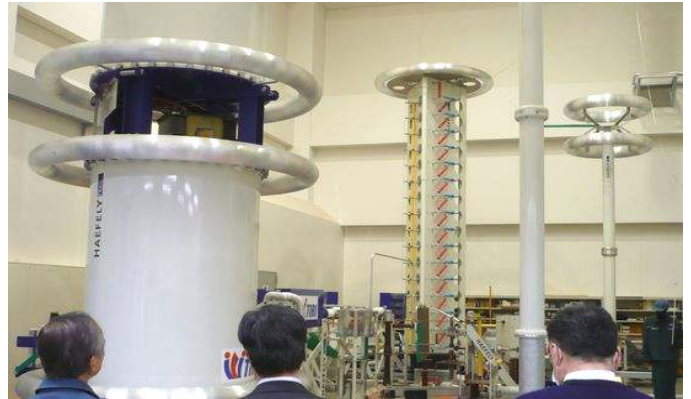
大型装置が立ち並ぶ高電圧実験室
