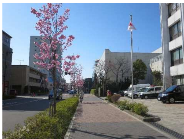
▲無電柱化を実施した道路（千住間道）
