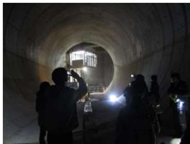
白子川地下調節池
