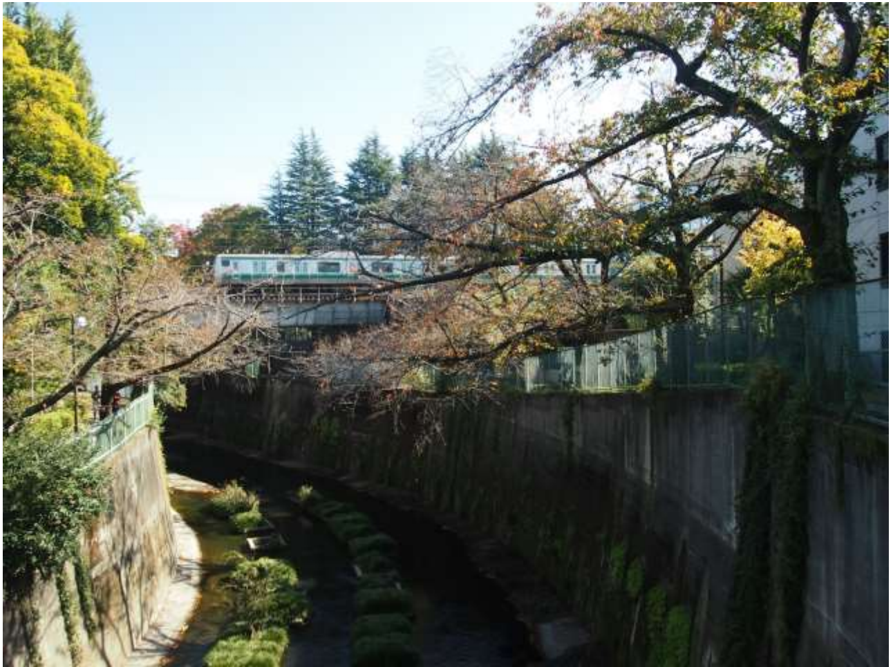
石神井川 東橋より下流を望む(埼京線)
