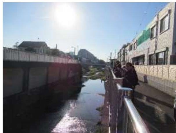
比丘尼橋上流調節池
