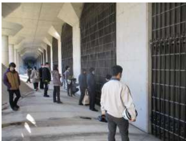
比丘尼橋下流調節池
